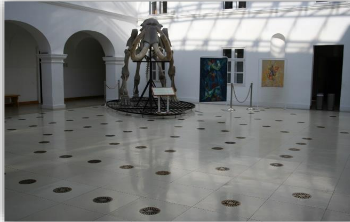
A belső udvar hűtés-fűtésrendszere
