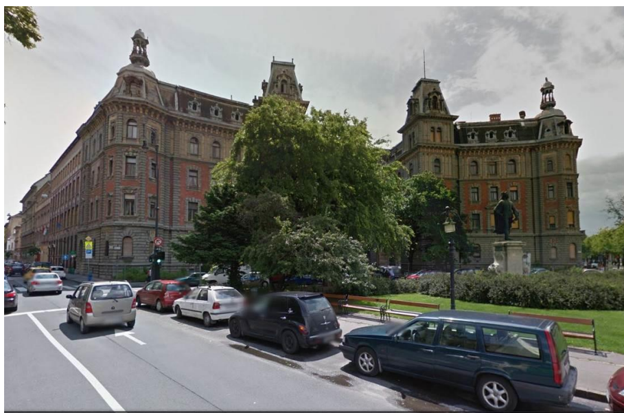
1. sz. fénykép. Az épület a Körönd felől
