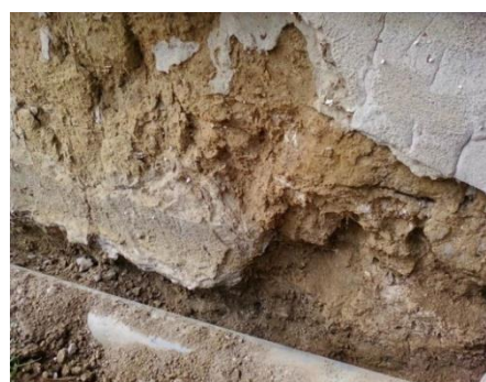
föld- és vályogfalak hidrofobizálása
