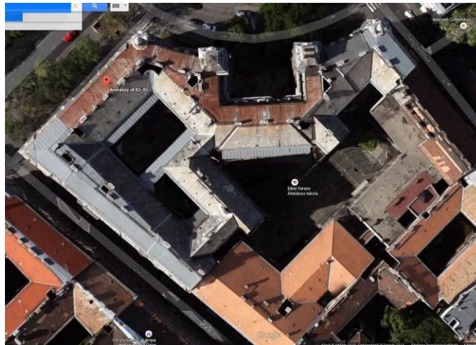
2. sz. fénykép. Az épület tetőfelülnézete
