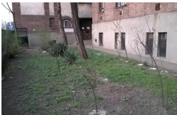
9. ábra: „B” probléma: a tetőn összegyűlt csapadékvizet a csatornába vezetik; a kialakított zöldfelület nem jut elég vízhez, a csatorna pedig túlterhelt (forrás: saját fénykép)
