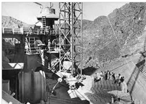
Imagen de las obras en el Cenajo (Fuente: Alumbre Alumbra)
