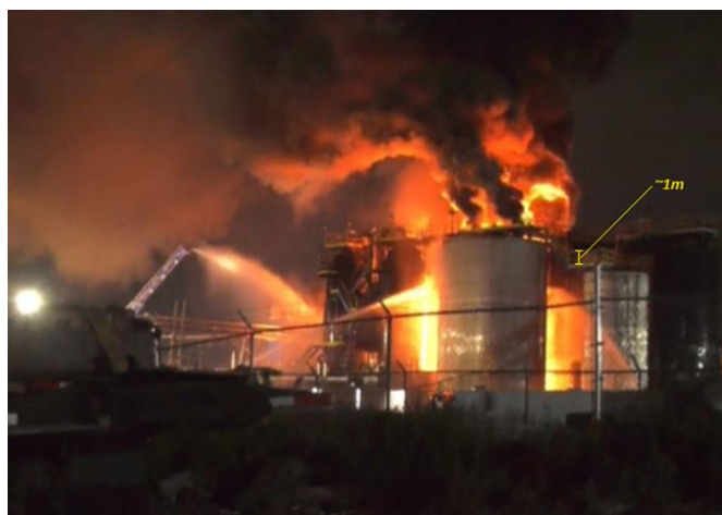
3. ábra Aszfalttároló tartály tüzesete [4]
